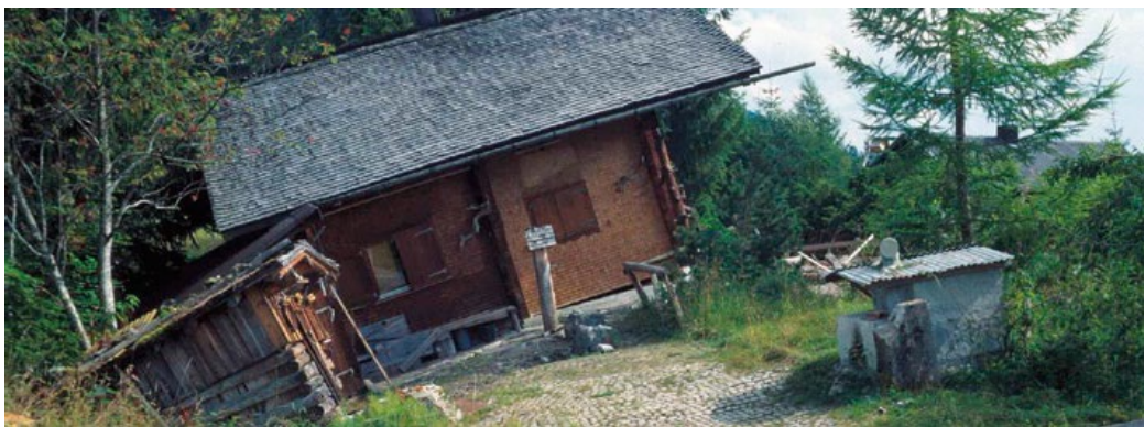
Durch Rutschung schief gestelltes Ferienhaus
